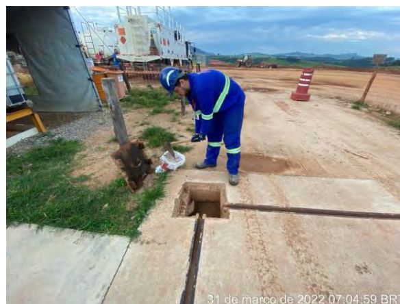
Foto 315 – Manutenção da Caixa SAO do tanque de combustível. (Data: 31/03/2022)
