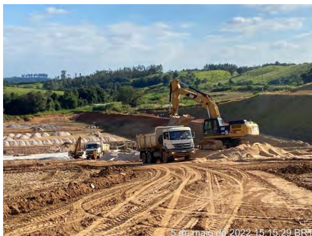
Foto 408 – Movimentação de terra, margem direita. (Data:05/05/2022)
