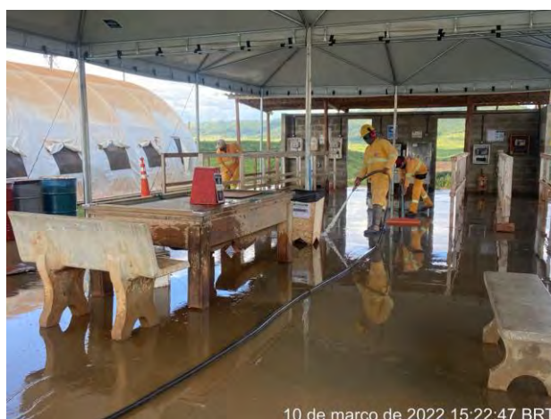
Foto 105 – Limpeza da área de vivencia canteiro industrial. (Data:10/03/2022)
