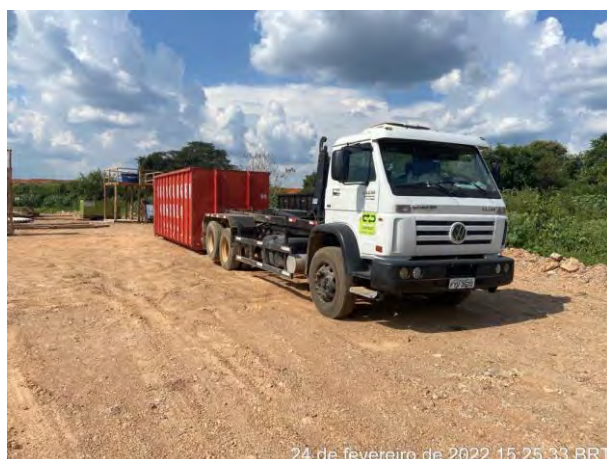
Foto 362 – Troca de caçambas de resíduos de madeira do canteiro industrial. (Data:24/02/2022)
