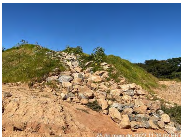
Foto 288 – Enrocamento com disciplinamento do fluxo para as caixas de retenção. (Data:25/05/2022).
