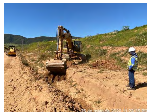
Foto 291 – Disciplinamento de águas pluviais. (Data: 25/05/2022)
