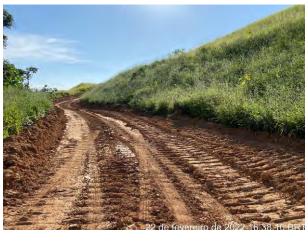
Foto 245 – Barreira de retenção de sedimentos no plato do Bota fora. (Data: 22/02/2022)
