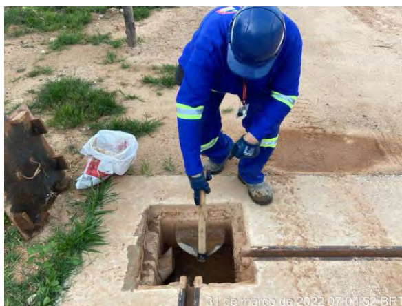
Foto 314 – Limpeza da Caixa SAO do tanque de combustível. (Data: 31/03/2022)
