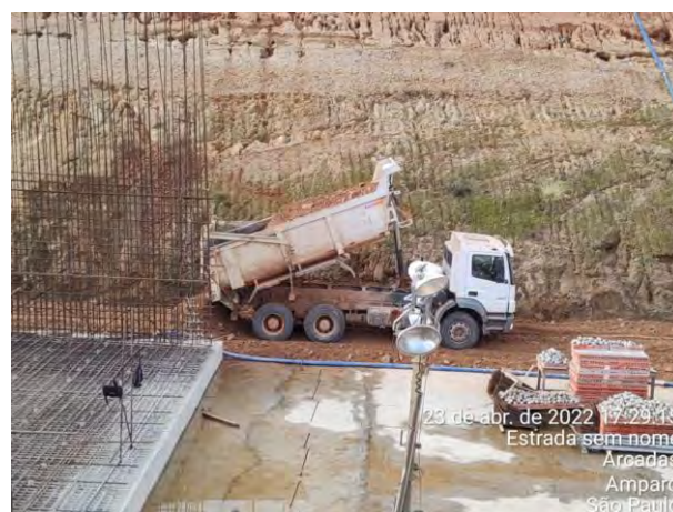
Foto 407 – Movimentação de terra, margem esquerda acesso aos módulos. (Data: 23/04/2022)
