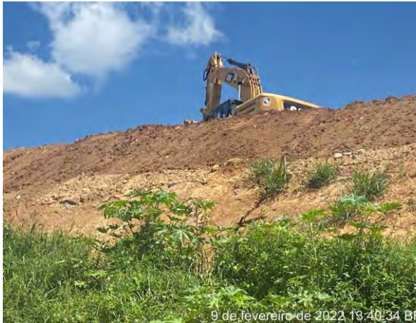
Foto 268 – Compactação e arrefeçoamento do talude. (Data: 09/02/2022)
