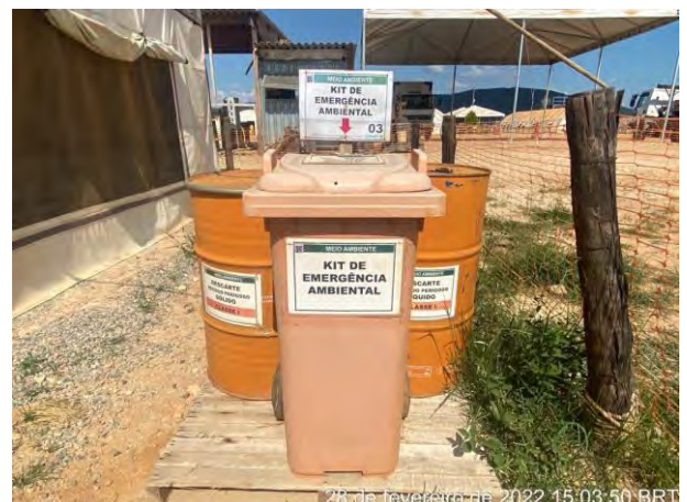
Foto 92 – Kit de atendimento a emergência no Ponto 03, MD Posto de abastecimento. (Data:28/02/2022)
