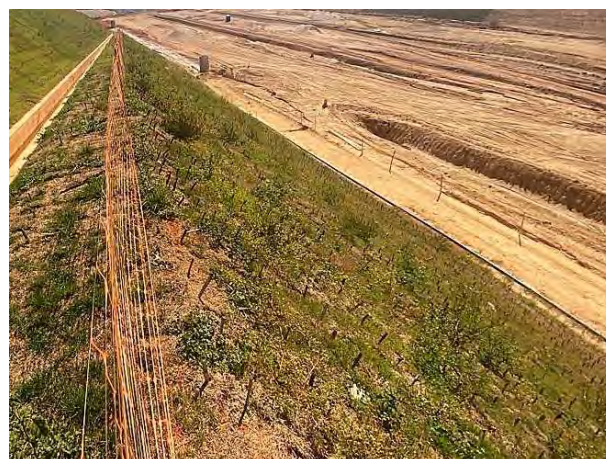
Foto 294 – canaleta de drenagem. (Data:17/02/2022)
