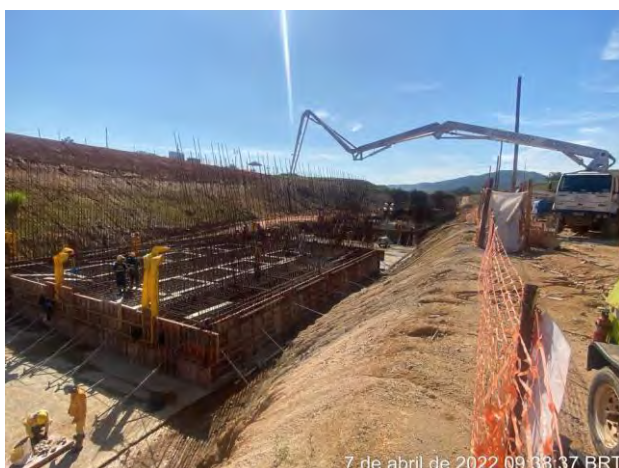
Foto 402 – Concretagem do canal de desvio modulo 6. (Data:07/04/2022)
