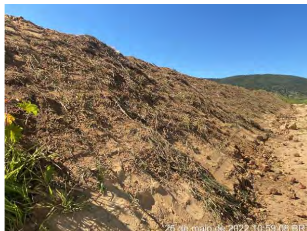
Foto 287 – Material vegetal aplicado no talude. (Data: 25/05/2022)
