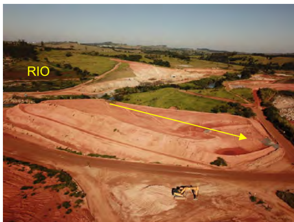
Foto 234 – Seta indica inclinação e direcionamento do platô para o acesso interno. Vista leste (Data:05/05/2022)
