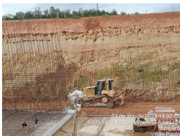
Foto 406 – Movimentação de terra, margem esquerda acesso aos módulos. (Data:23/04/2022)
