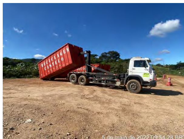
Foto 381 – Troca de caçambas de resíduos comum canteiro industrial. (Data:05/05/2022).
