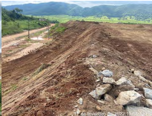
Foto 271 – Vista para compactação do talude. (Data: 17/02/2022)
