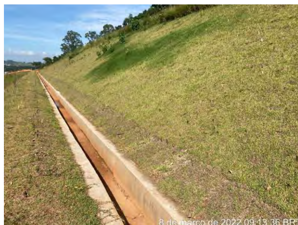
Foto 296 – canaleta de drenagem. (Data:08/03/2022)
