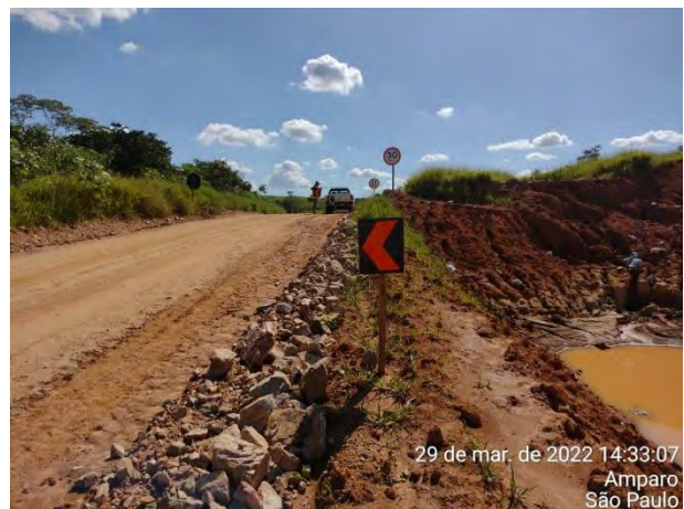
Foto 204 – Sinalização de acesso, MD interno da obra. (Data: 29/03/2022)
