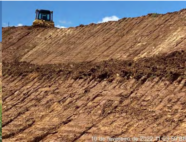
Foto 269 – Colocação de solo com material vegetal. (Data: 10/02/2022)
