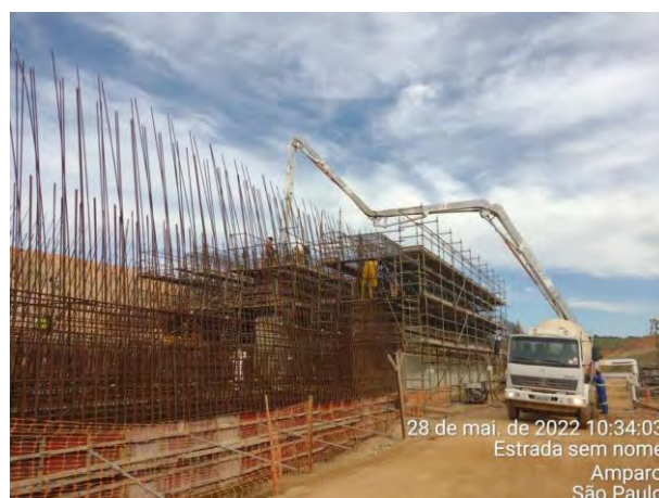
Foto 413 – Concretagem do canal de desvio modulo 4. (Data: 28/05/2022)
