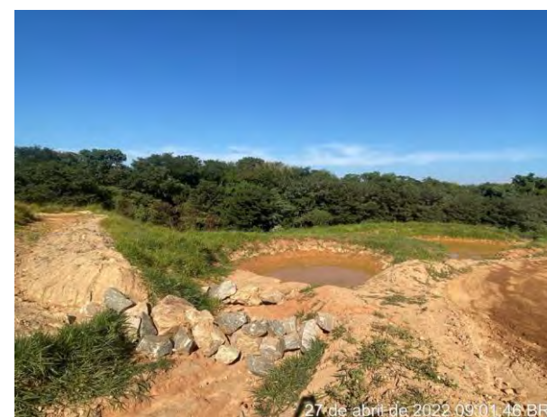
Foto 285 – Cacimba de retenção de sedimento (Data: 27/04/2022)
