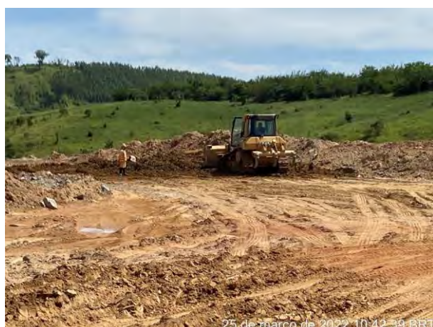
Foto 398 – Movimentação de terra bota fora 01. (Data:25/03/2022)
