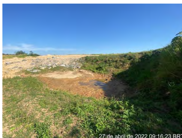
Foto 258 – Cacimba de contenção. (Data: 27/04/2022)
