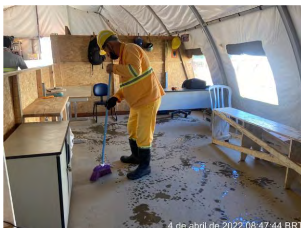
Foto 111 – Limpeza do escritório canteiro industrial. (Data:04/04/2022)
