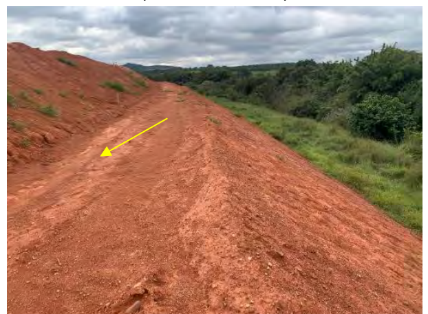
Foto 237 – Vista para leira e inclinação e direcionamento para saída do talude (Data:05/05/2022)
