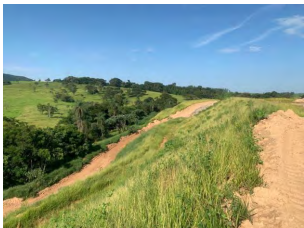
Foto 249 – Cobertura vegetal, leira e canaletão. (Data: 09/03/2022)
