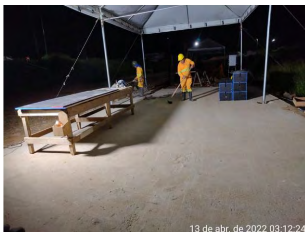
Foto 113 – Limpeza da área da carpintaria canteiro industrial. (Data: 13/04/2022)
