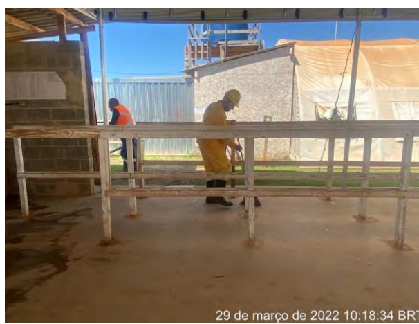
Foto 106 – Limpeza da área de vivencia canteiro industrial. (Data:29/03/2022)
