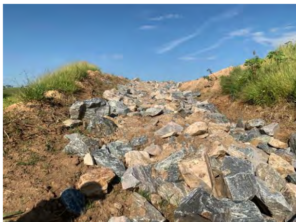
Foto 251 – Vista para o enrocamento com rocha para retenção de sólidos, Bota fora. (Data: 09/03/2022)
