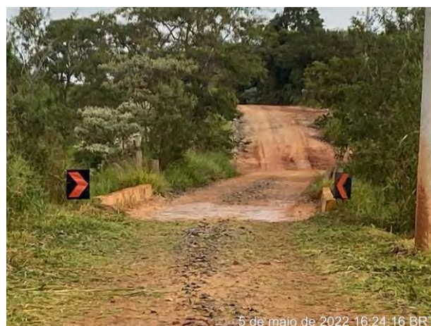
Foto 208 – Sinalização de acesso interno da Obra. (Data: 05/05/2022)
