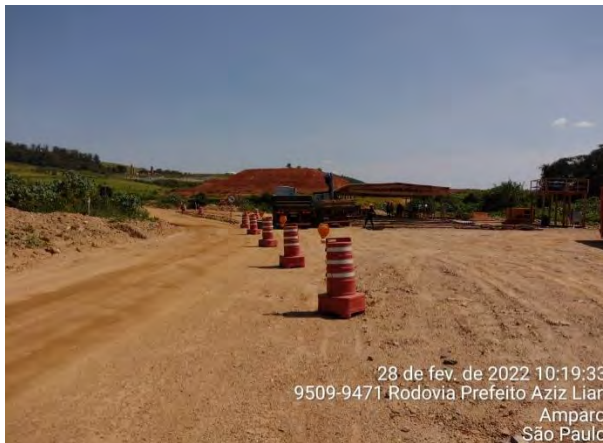
Foto 201 – Sinalização do acesso interno da obra. (Data: 28/02/2022)
