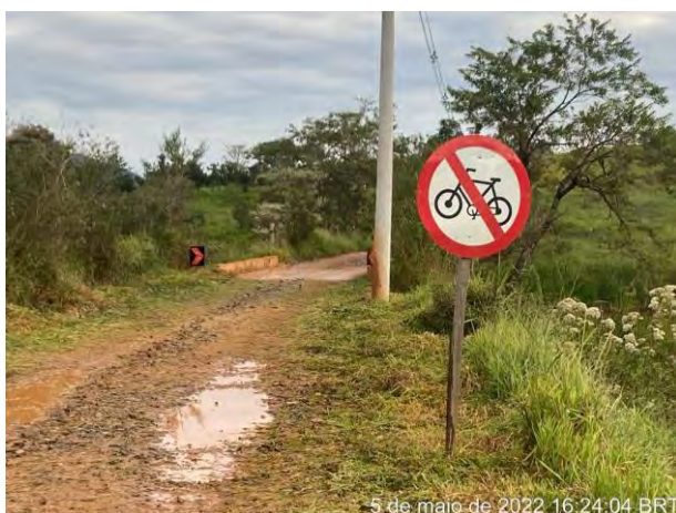
Foto 207 – Sinalização do acesso interno da Obra. (Data: 05/05/2022)
