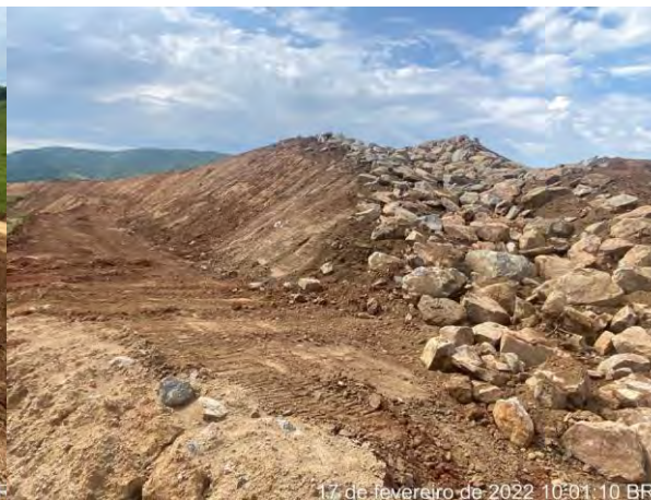
Foto 273 – Vista para o enrocamento com rocha para retenção de sólidos. (Data: 17/02/2022)
