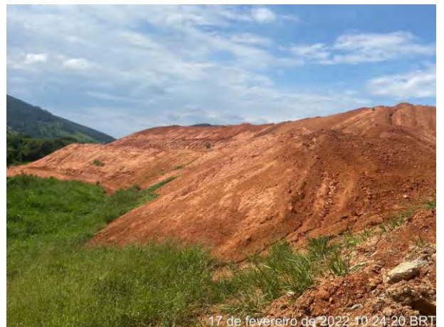
Foto 211 – Vista para cobertura vegetal na leira de proteção do BE (Data:17/02/2022)
