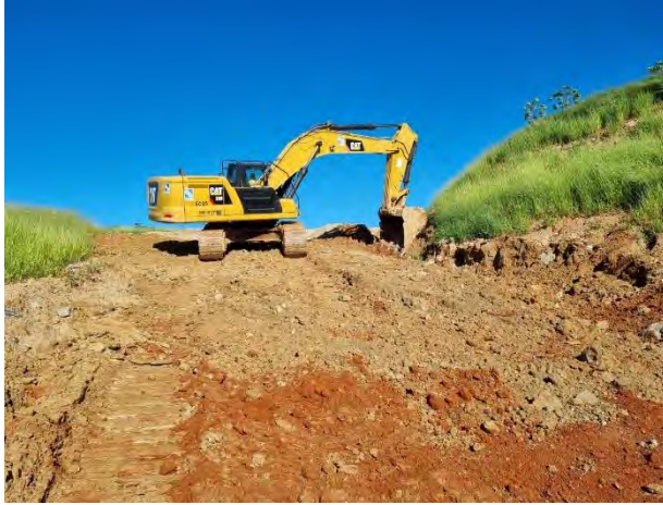
Foto 390 – Movimentação de terra Bota fora I. (Data:18/02/2022)
