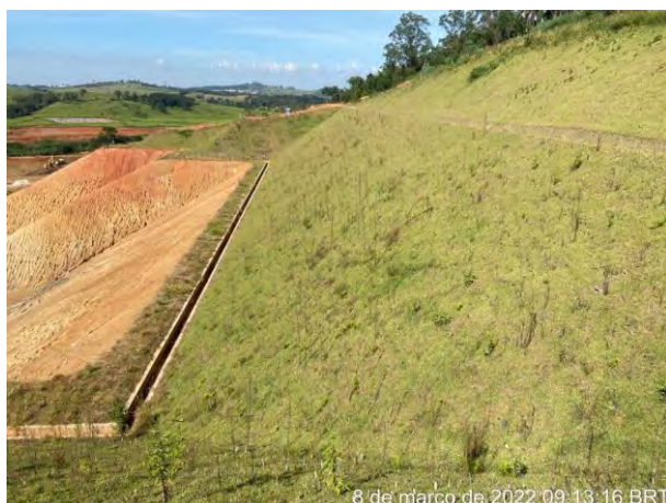
Foto 295 – Canaletas de drenagem. (Data:08/03/2022)
