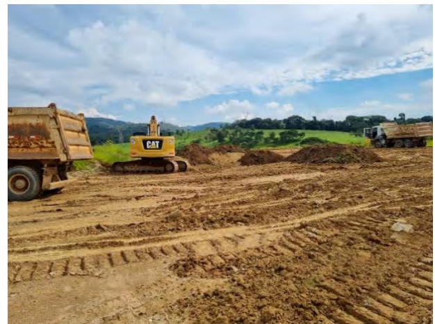
Foto 395 – Movimentação de terra Bota fora I. (Data:18/02/2022)
