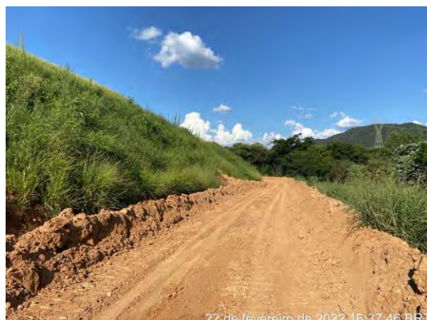
Foto 244 – Material vegetal, leira e canaletão. (Data: 22/02/2022)
