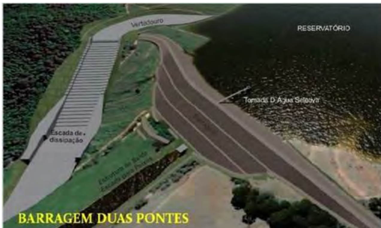
Figura 1 – Projeção da futura Barragem Duas Pontes
