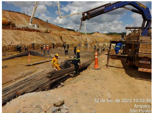
Foto 393 – Limpeza do canal de adução do canal de desvio. (Data:12/02/2022)
