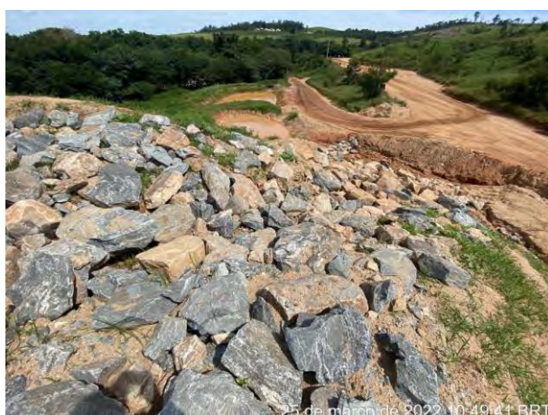
Foto 278 – Enrocamento com disciplinamento do fluxo para as caixas de retenção. (Data: 25/03/2022)
