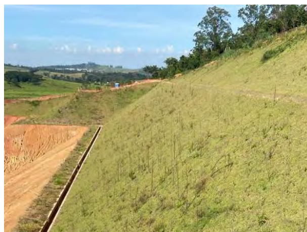
Foto 298 – canaleta de drenagem. (Data:14/04/2022)
