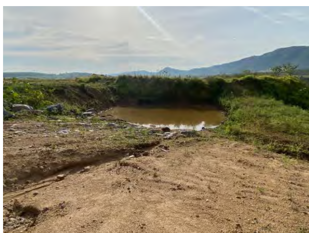
Foto 263 – Cacimba de contenção. (Data: 31/05/2022)
