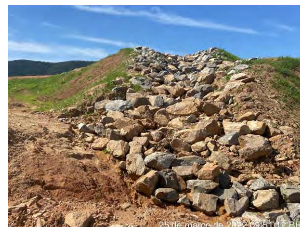
Foto 279 – Vista para o enrocamento com rocha para retenção de sólidos. (Data: 25/03/2022)
