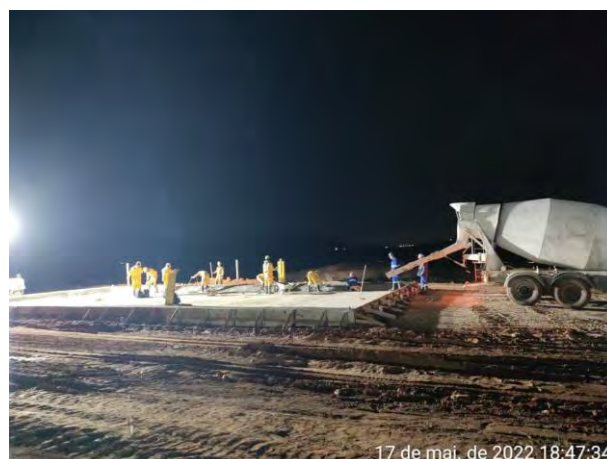
Foto 411 – Aplicação de Concreto. (Data:17/05/2022)
