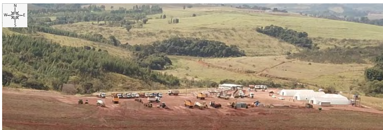
Foto 303 – Canteiro industrial. (Ilustrativo)
