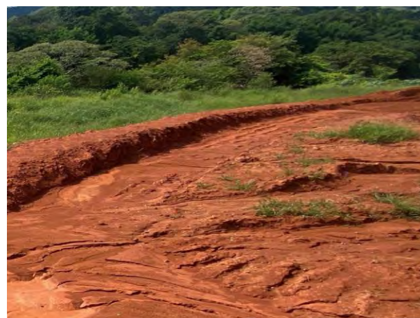
Foto 223 – Vista para inclinação e direcionamento do platô. Leira de solo entre as bermas do talude do bota espera. (Data:12/04/2022)
