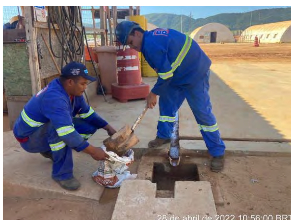
Foto 316 – Limpeza da primeira caixa de inspeção e canaletas da área de manutenção. (Data: 28/04/2022)
