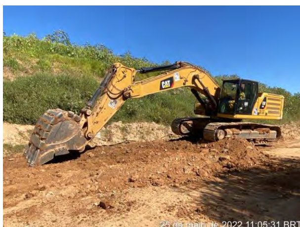
Foto 290 – Disciplinamento de águas pluviais. (Data: 25/05/2022)
