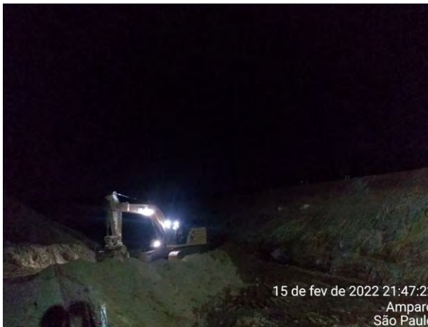
Foto 392 – Escavação Galeria margem esquerda. (Data:15/02/2022)
