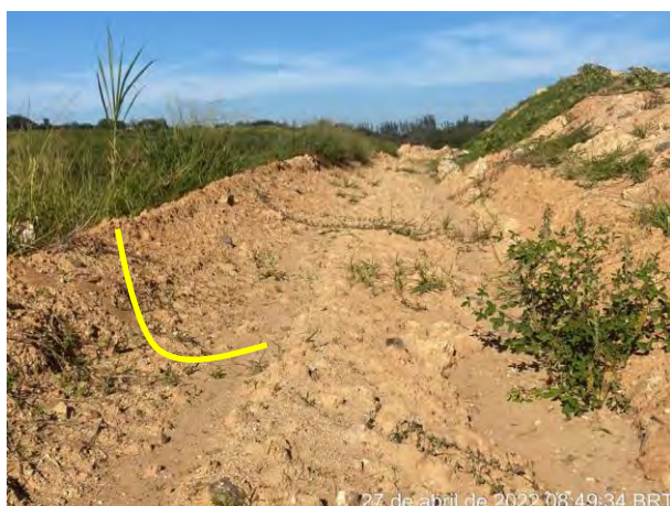
Foto 282 – Barreira de retenção de sedimentos e canaleta. (Data:27/04/2022).
