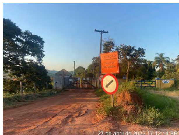
Foto 198 – Via municipal de acesso a obra. (Data:27/04/2022)
