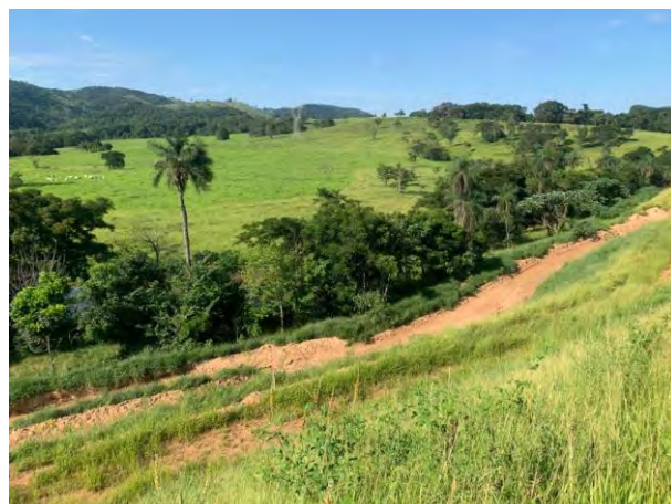
Foto 252 – Material vegetal, leira e canaletão. (Data: 09/03/2022)
