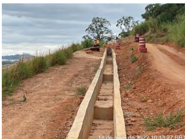
Foto 299 – Canaletas definitiva de drenagem. (Data:18/05/2022)
