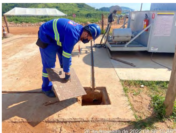
Foto 312 – Limpeza da Caixa SAO do tanque de combustível. (Data: 26/02/2022)
