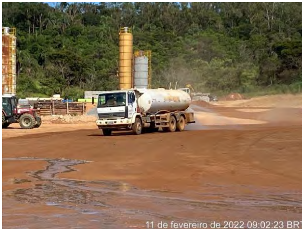
Foto 328 – Umectação de vias internas. (Data:11/02/2022)
