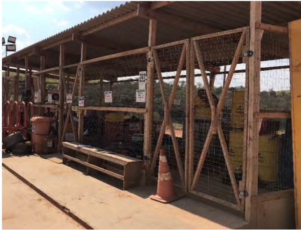
Foto 87 – Baía para armazenamento de produto químico. (Data:26/04/2022)
