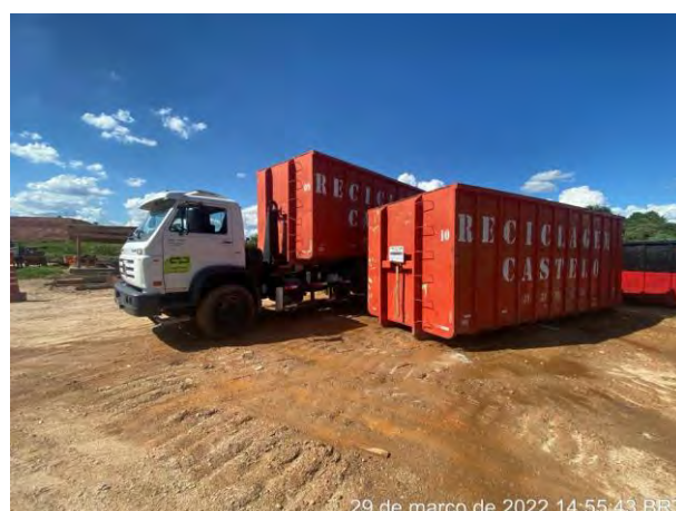
Foto 369 – Troca da caçamba de resíduo de metal. (Data:29/03/2022).
