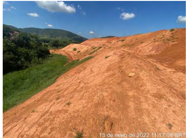
Foto 233 – Vista para inclinação e direcionamento do platô. Leira de solo entre as bermas do talude do bota espera. (Data:13/05/2022)
