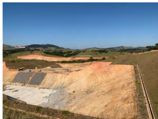
Foto 302 – Canaleta de drenagem. (Data:25/05/2022)
