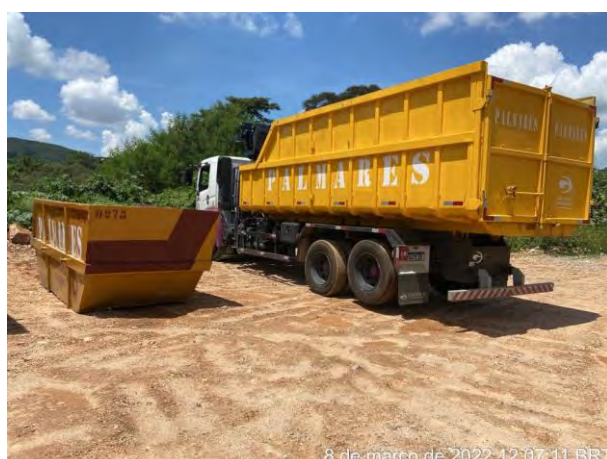
Foto 368 – Troca de caçambas de resíduos de madeira do canteiro industrial. (Data:08/03/2022)
