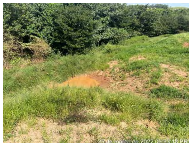
Foto 277 – Cacimba de retenção de sedimento. (Data: 25/03/2022)
