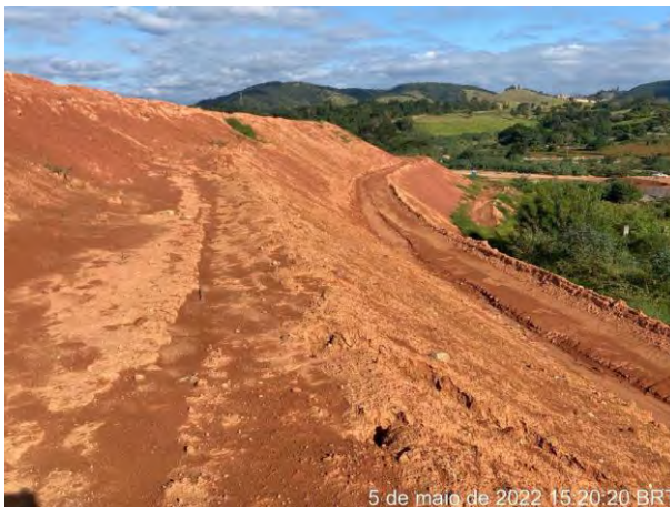
Foto 228 – Leira de proteção no entorno do bota espera com inclinação para a saia do talude. (Data: 05/05/2022)
