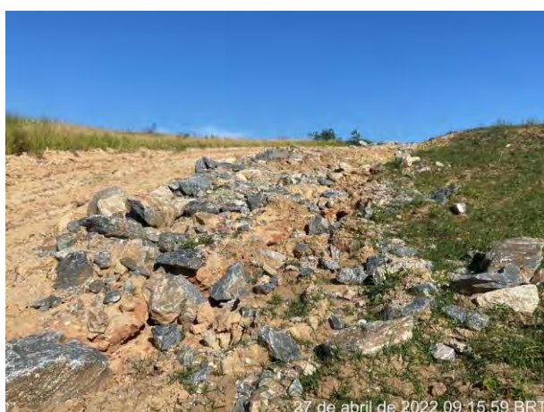
Foto 257 – Vista para o enrocamento com rocha para retenção de sólidos, Bota fora. (Data: 27/04/2022)
