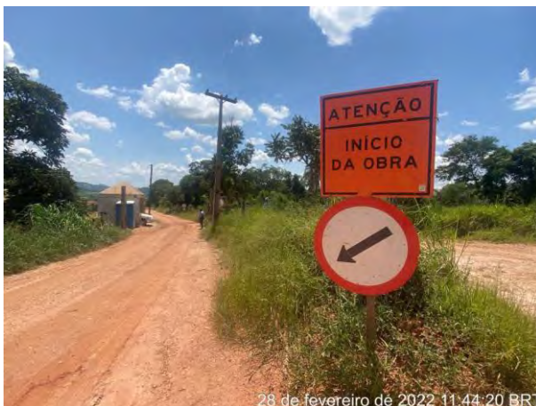
Foto 193 – Via municipal de acesso a obra. (Data:28/02/2022)
