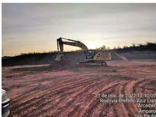
Foto 412 – Movimentação de terra vertedouro. (Data:21/05/2022)
