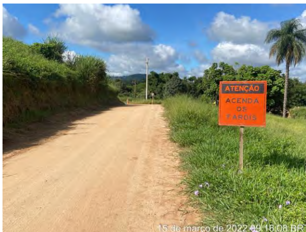
Foto 203 – Sinalização do acesso interno da obra. (Data: 15/03/2022)
