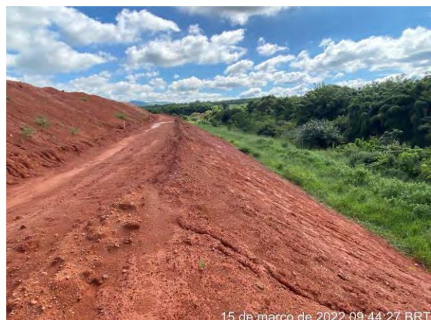
Foto 217 – Vista para inclinação e direcionamento do platô. Leira de solo entre as bermas do talude do bota espera. (Data:15/03/2022)
