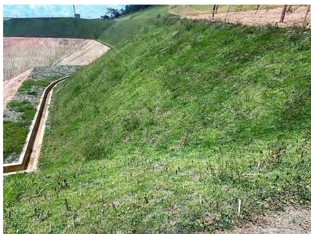
Foto 293 – Canaletas de drenagem. (Data:17/02/2022)
