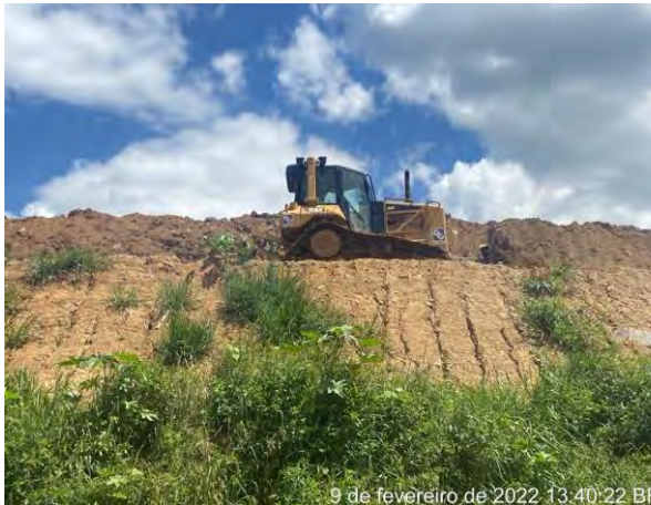
Foto 270 – Direcionamento e aperfeiçoamento das bermas. (Data:09/02/2022).
