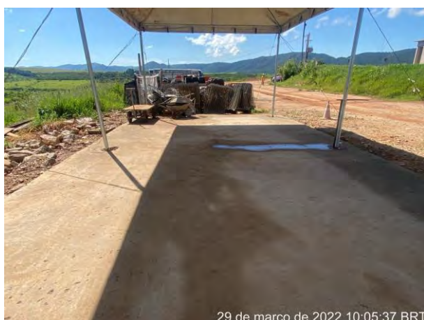
Foto 109 – Limpeza da área da carpintaria canteiro industrial. Ronda 0215. (Data:29/03/2022)
