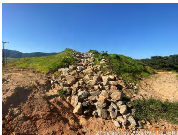
Foto 284 – Enrocamento com disciplinamento do fluxo para as caixas de retenção. (Data: 27/04/2022)
