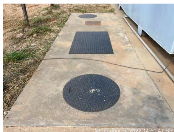
Foto 317 – Inspeção na Caixa SAO do tanque de combustível. (Data: 27/04/2022)
