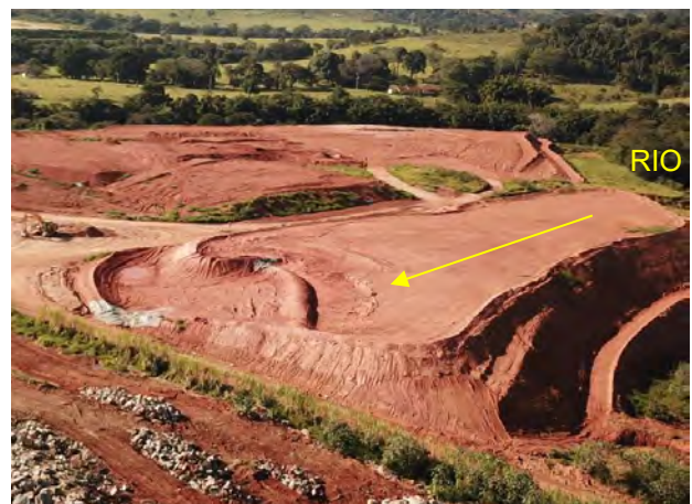
Foto 235 – Seta indica inclinação e direcionamento. Leira de solo entre na crista do talude. Cacimba e manta geotêxtil para retenção do fluxo Vista oeste. (Data:13/05/2022)
