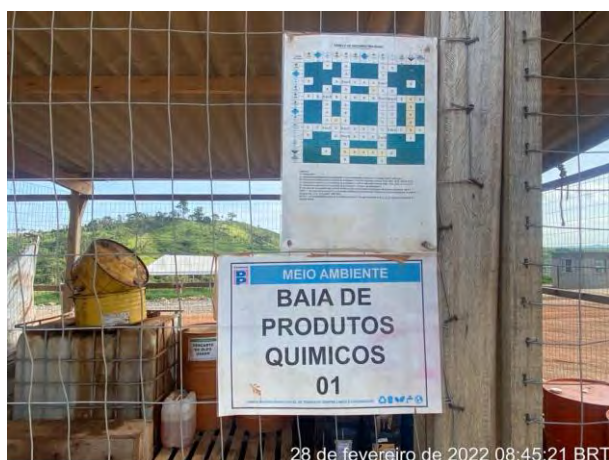
Foto 81 – Baia para armazenamento de produto químico. (Data:28/02/2022)
