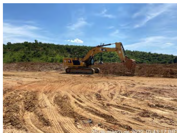
Foto 399 – Movimentação de terra bota fora 01. (Data:25/03/2022)
