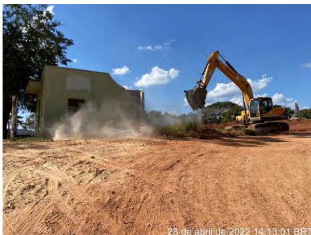
Foto 382 – Demolição da estrutura 126. (Data:28/04/2022)
