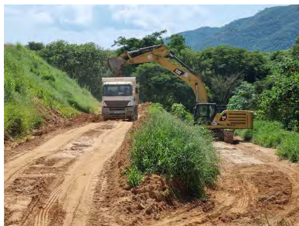
Foto 246 – Manutenção de cacimba e canaletão. (Data: 22/02/2022)
