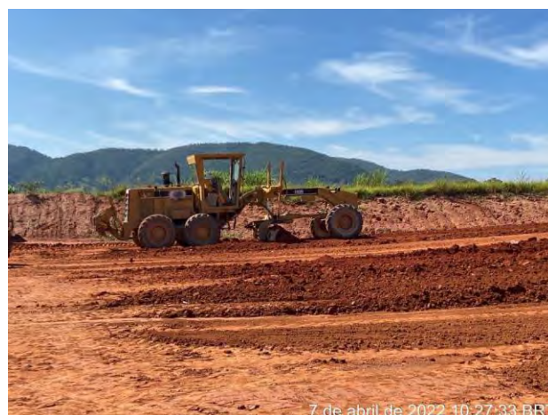
Foto 403 – Movimentação de terra. (Data:07/04/2022)
