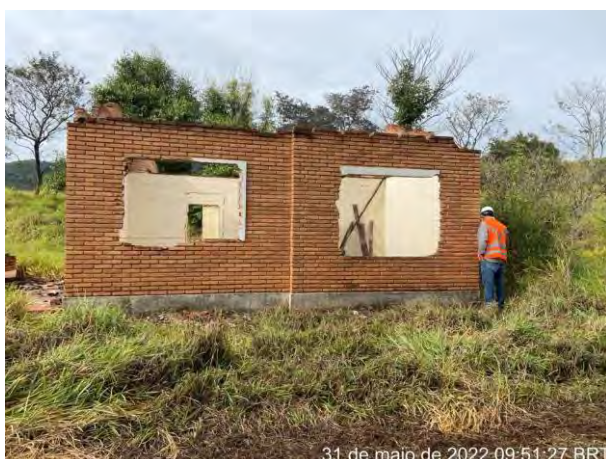
Foto 386 – Demolição da estrutura 02 Fazenda Jatai. (Data:31/05/2022)
