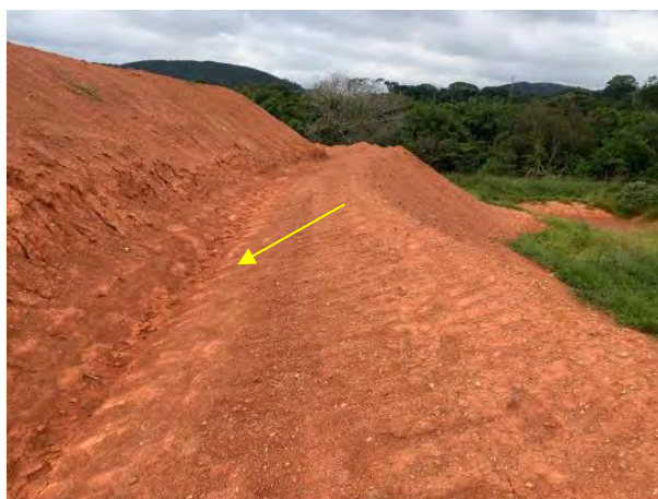
Foto 236 – Vista para leira e inclinação e direcionamento para saída do talude (Data:05/05/2022)
