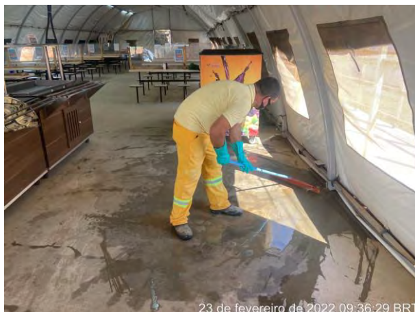
Foto 101 – Limpeza da área de vivência no canteiro industrial. (Data:23/02/2022)
