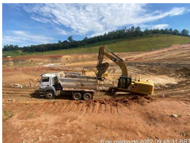
Foto 396 – Movimentação de terra vertedouro MD. (Data:08/03/2022)
