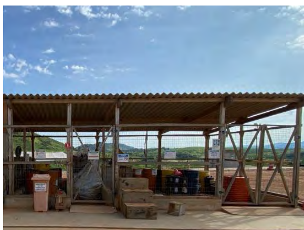
Foto 83 – Baia para armazenamento de produto químico. (Data:31/03/2022)
