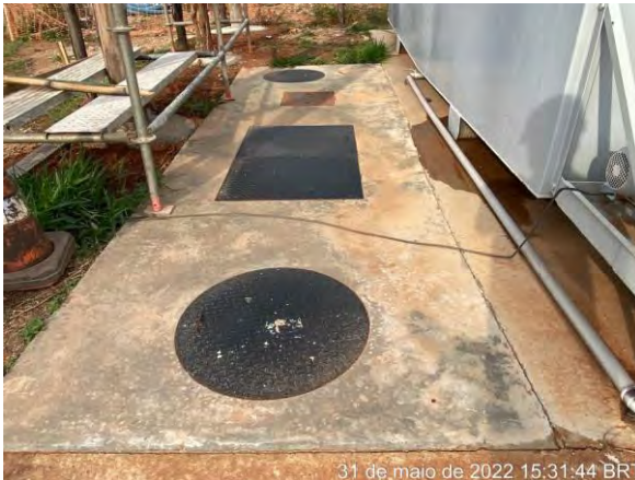
Foto 318 – Inspeção na Caixa SAO do tanque de combustível (Data: 31/05/2022)
