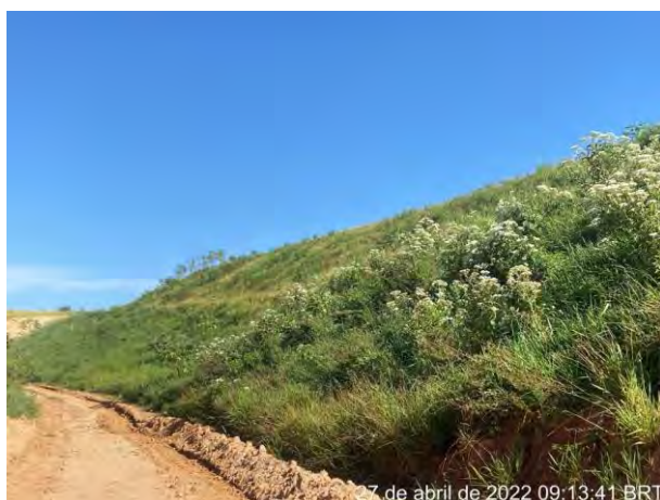
Foto 255 – Cobertura vegetal, leira e canaletão. (Data: 27/04/2022)
