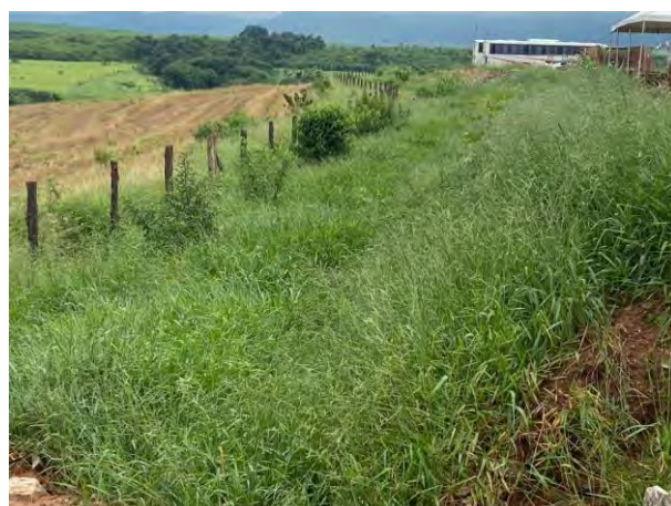
Foto 305 – Implantação de dispositivos de drenagem próximo ao canteiro industrial. (Data:13/02/2022)
