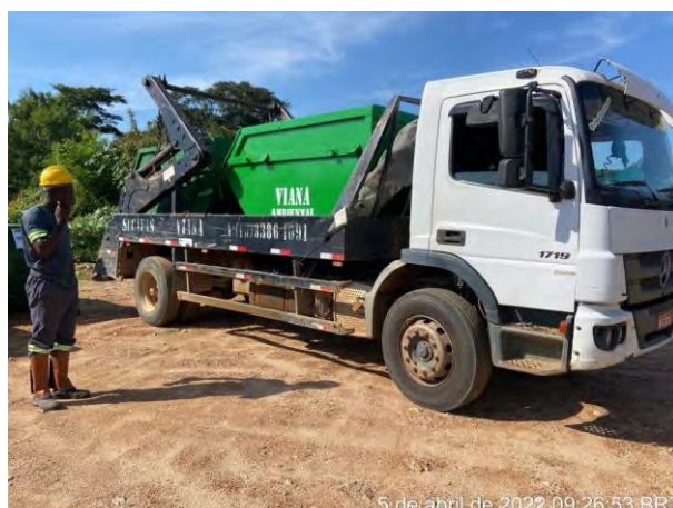
Foto 374 – Troca de caçambas de resíduos de comum no canteiro ADM. (Data:05/04/2022)
