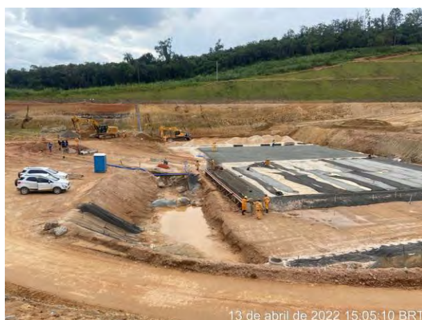
Foto 404 – Regularização da bacia de dissipação. (Data:13/04/2022)
