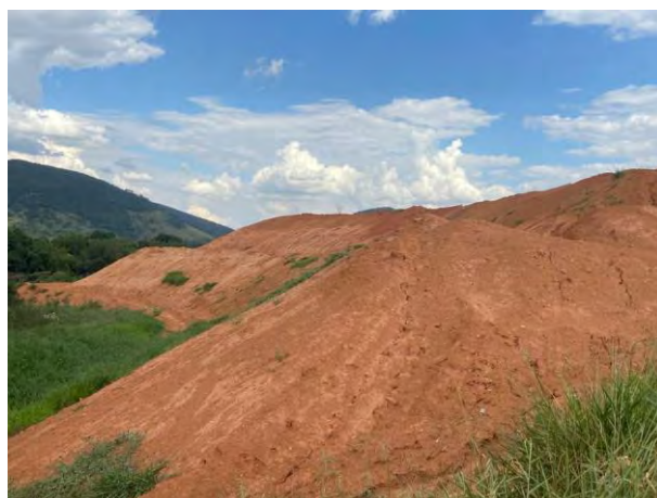
Foto 222 – Canaleta e leira de proteção no entorno do bota espera com inclinação para a saída do talude. (Data: 12/04/2022)
