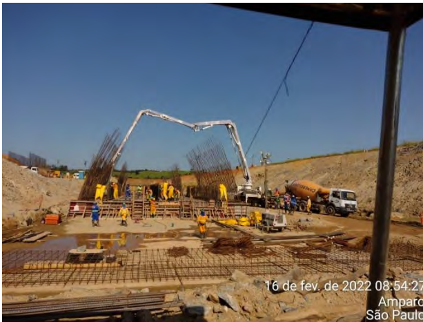
Foto 394 – Concretagem do módulo 02 canal de desvio. (Data:16/02/2022)
