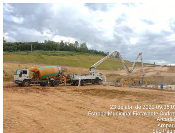
Foto 405 – Aplicação de Concreto magro da bacia de dissipação. (Data:23/04/2022)
