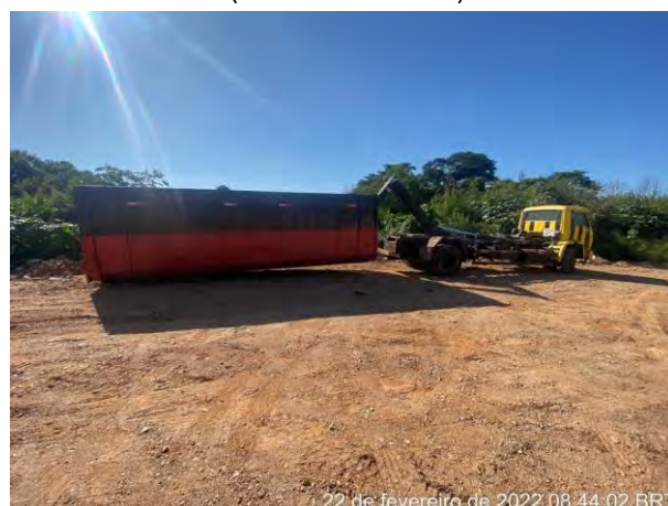
Foto 363 – Troca da caçamba de resíduo de metal. (Data:22/02/2022).
