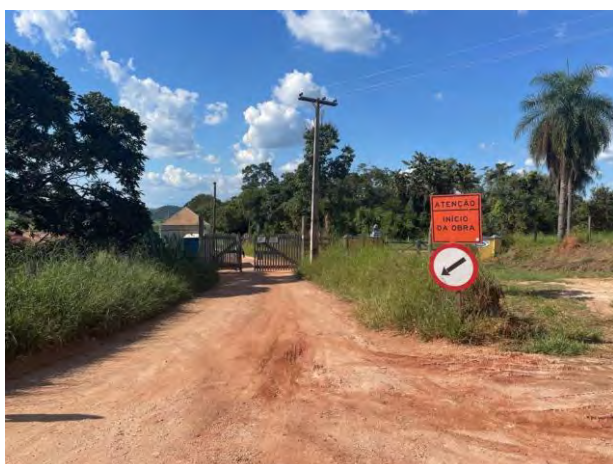
Foto 195 – Via municipal de acesso a obra. (Data:09/03/2022)
