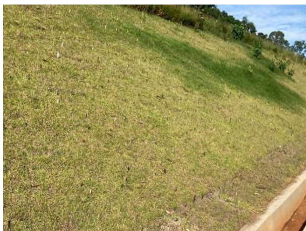
Foto 297 – Canaletas de drenagem. (Data:14/04/2022)
