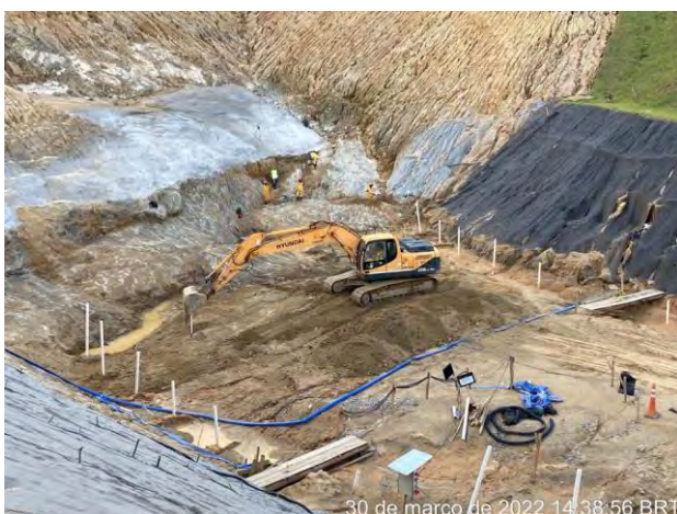
Foto 400 – Movimentação de terra vertedouro. (Data:30/03/2022)
