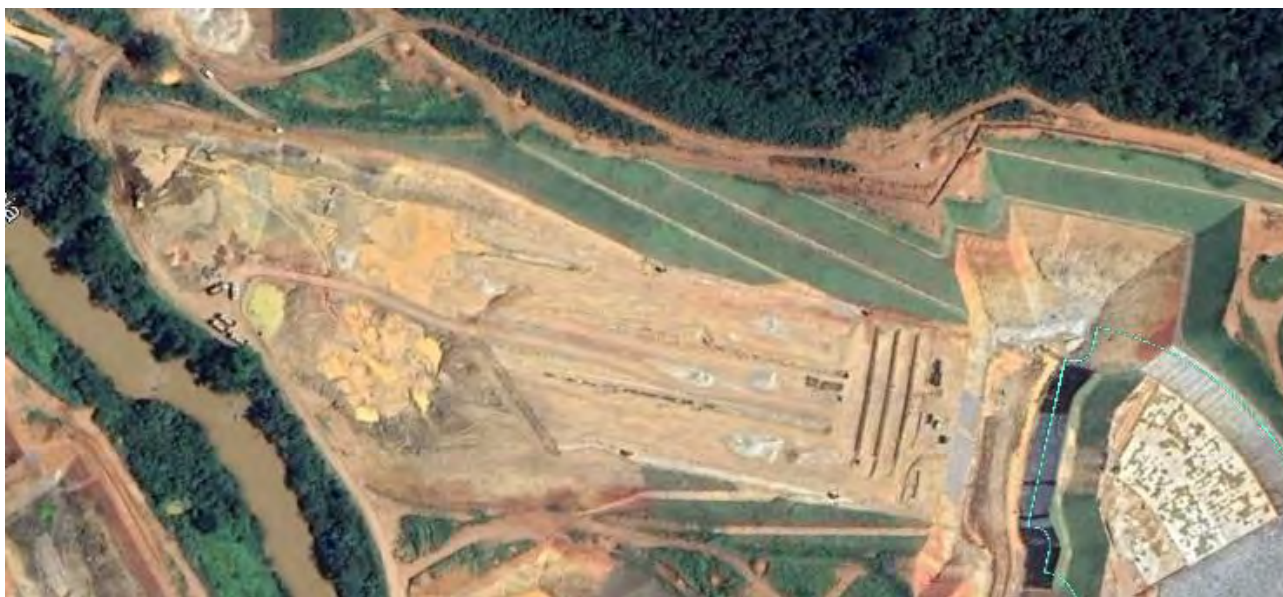
Foto 292 – Talude do Vertedouro. (Ilustrativo)
