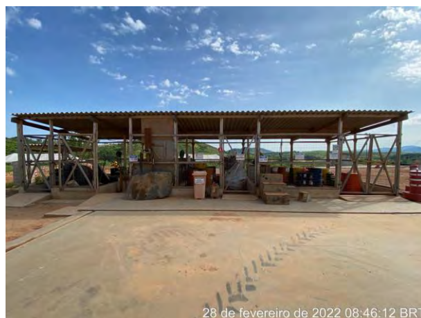
Foto 82 – Placas de comunicação no acesso a Baia de produto químico. (Data:28/02/2022)
