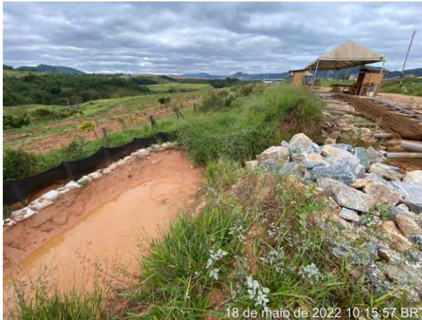
Foto 310 – Cacimba de contenção. (Data:18/05/2022)
