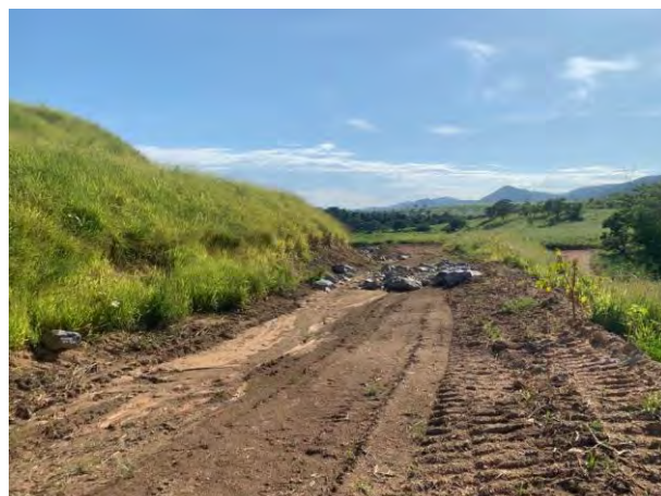
Foto 250 – Material vegetal, leira e canaletão. (Data: 09/03/2022)
