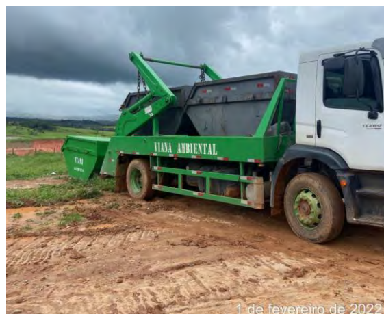
Foto 365 – Troca da caçamba de resíduo do canteiro industrial. (Data:01/02/2022)
