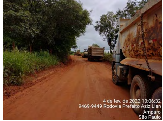
Foto 391 – Manutenção das estradas de acesso a obra. (Data:04/02/2022)
